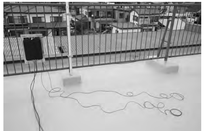
(写真3) アース(カウンターポイズ)を実際に取った例 撮影時は5mを2本取っている
