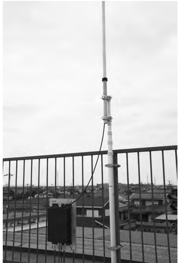
(写真2) ATUをマストから離して設置した例 ATUはCG3000
